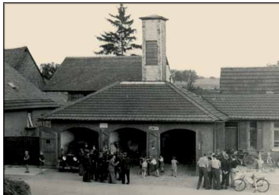
Das 1894 erbaute Spritzenhaus am „Dallas“, Ecke Mainzer / Messeler Strasse. Im linken Tor ist das erste Fahrzeug, ein Adler Favorit Junior, zu entdecken. Heute ist der Schlauchturm abgerissen und im Gebäude befindet sich eine Gaststätte. Das Bild entstand um 1950.
