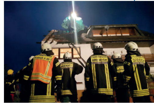
Teilweise abgedecktes Dach (ffo)
